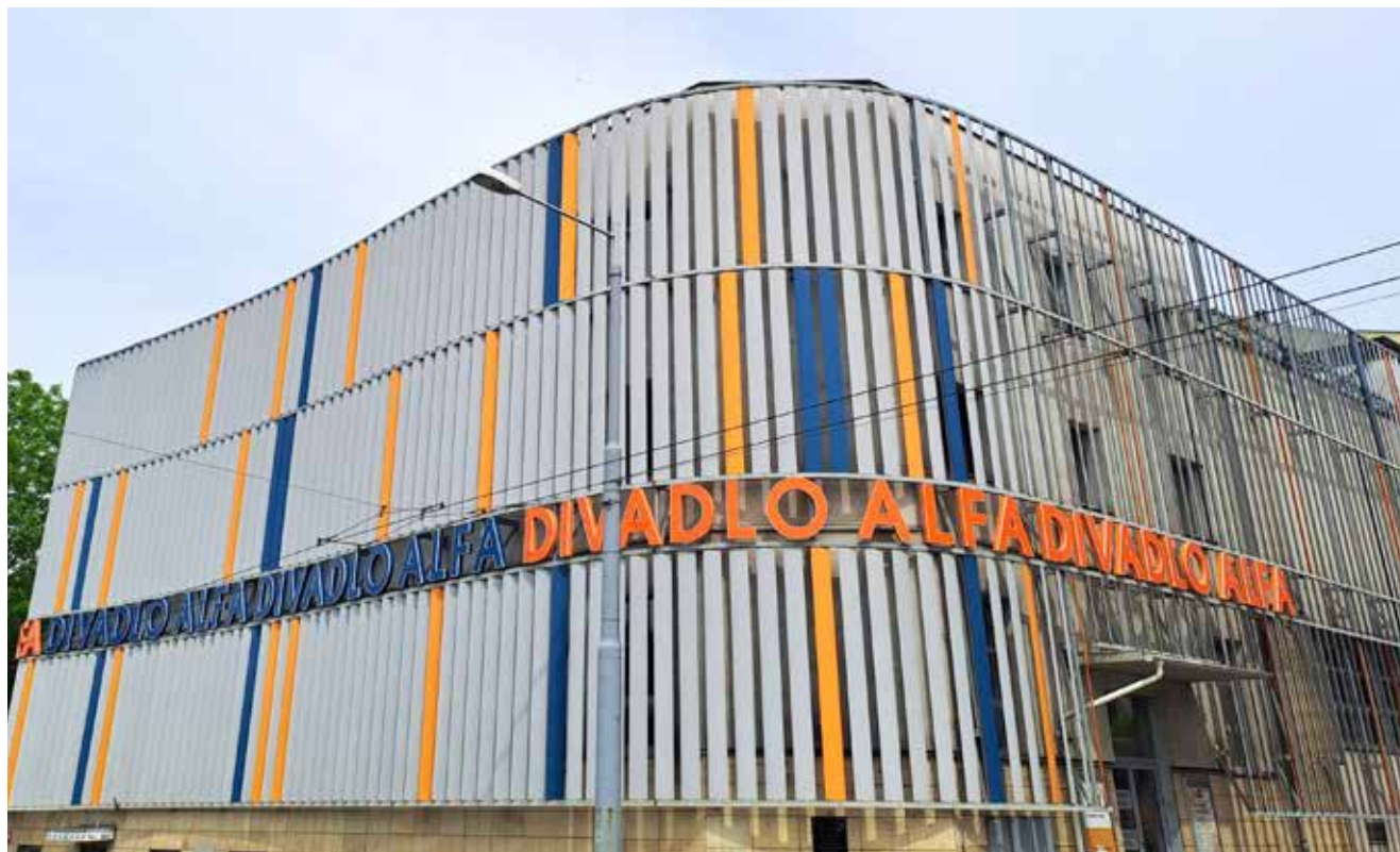
světelná reklama (písmena) na fasádě divadla
